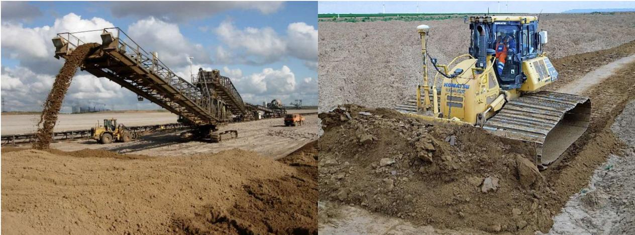
Durch die geringe Fallhöhe des Bodenmaterials muss nur wenig nachgearbeitet werden
